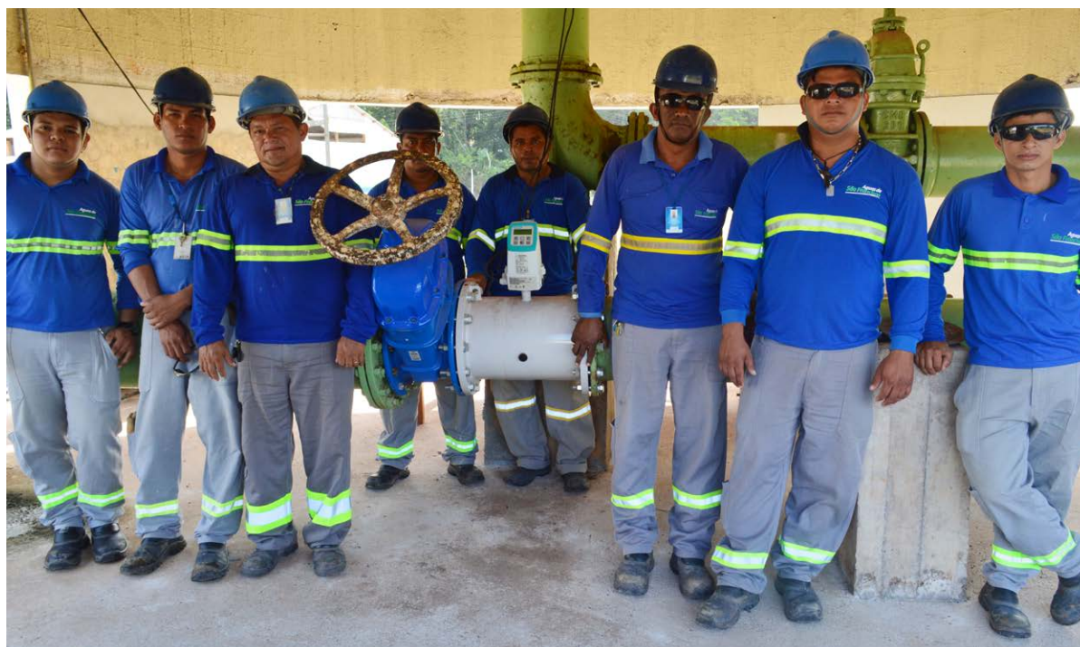
Equipe operacional da Águas de São Francisco que participou da instalação do macromedidor em Barcarena (PA).
