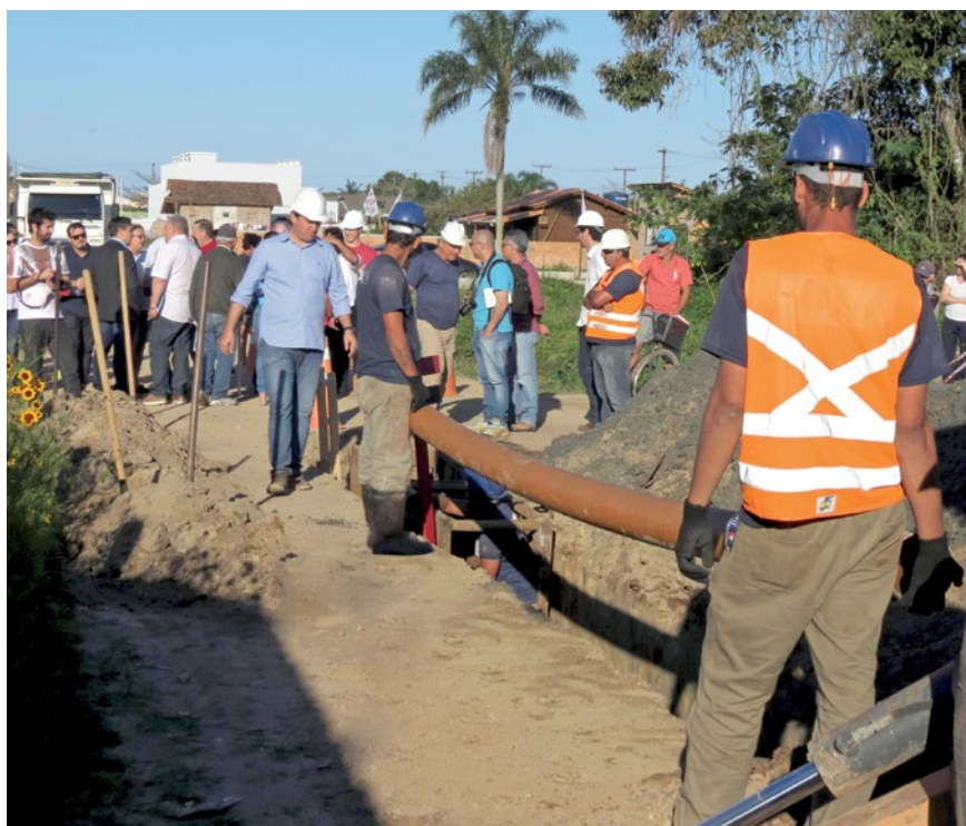
Instalação da primeira parte da rede do sistema de esgoto.
