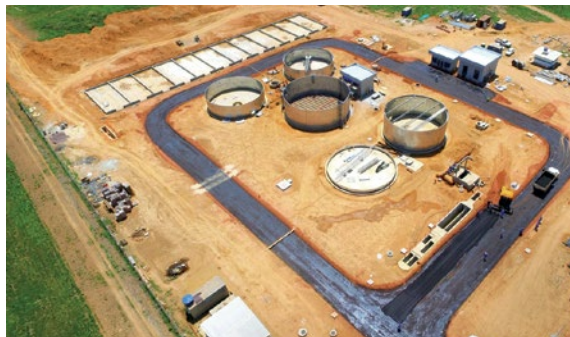
A ETE Curupy, em Sinop, terá capacidade para tratar 60 litros de esgoto por segundo.
