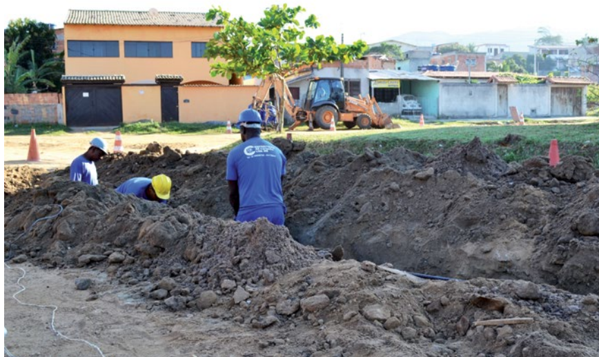
Prolagos realiza obras para implantação de rede exclusiva de coleta de esgoto.
