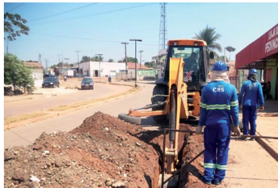
Bairros de Peixoto de Azevedo (MT) recebem a implantação da rede de esgotamento sanitário que beneficiará 70% da população.
