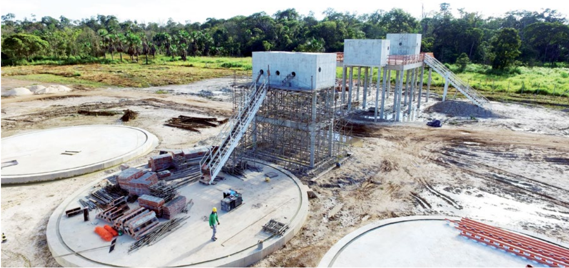
Estruturas das obras de construção da ETE Teles Pires em Sorriso (MT).
