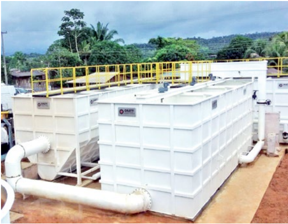
Nova ETA entra em operação ampliando o abastecimento para seis milhões de litros por dia.
