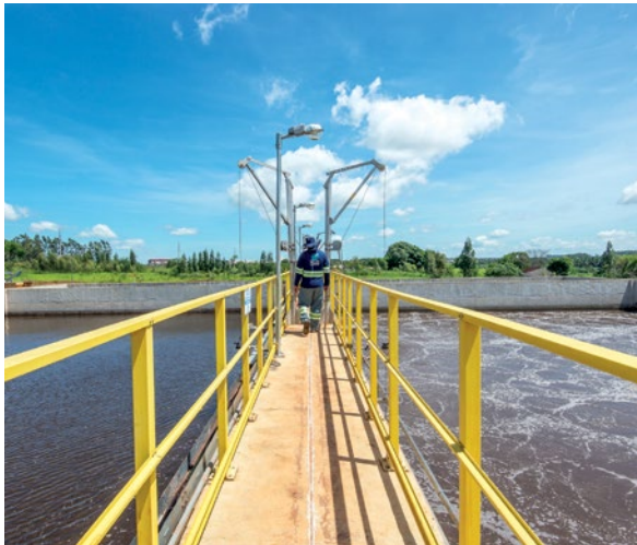
ETE Imbirussu, em Campo Grande, tem tecnologia pioneira no país e uma alta eficiência no tratamento do esgoto: 98%.
