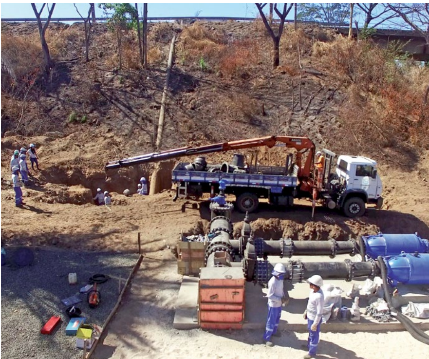
Obras realizadas para a instalação do booster – unidade de bombeamento de água – na zona sudeste da capital.
