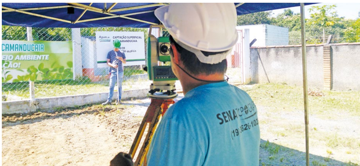
Realização dos serviços de topografia para implantação da rede coletora.
