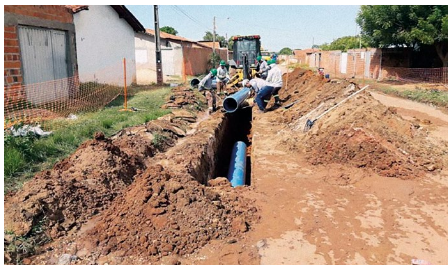
Obras da adutora Meio Norte, que terá 10 km de extensão e vai beneficiar 100 mil moradores da capital.
