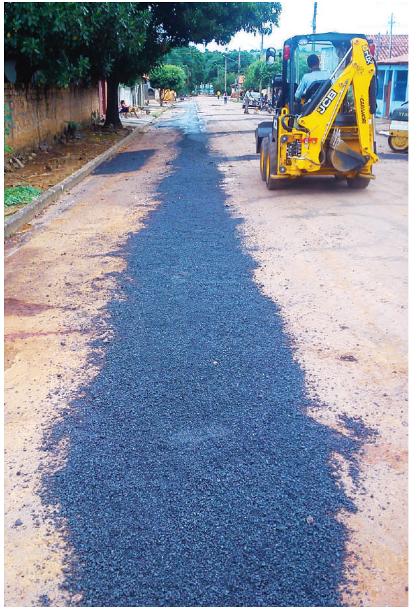
Obras de ampliação da rede de esgotamento sanitário na cidade de Pedra Preta (MT).
