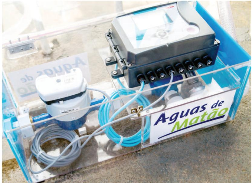
Equipamento exclusivo da Águas de Matão é instalado em série no hidrômetro do cliente.
