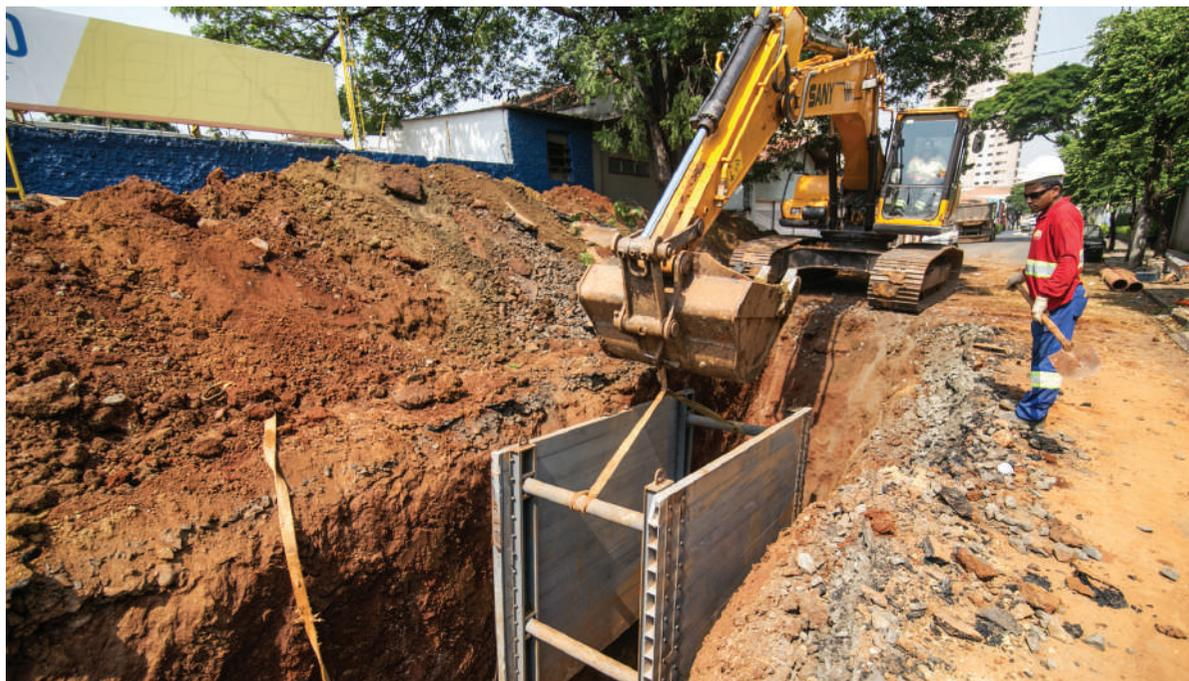
A readequação de rede coletora de esgoto, realizada na área central do município, tem o objetivo de evitar o lançamento de esgoto no Córrego do Itapeva.
