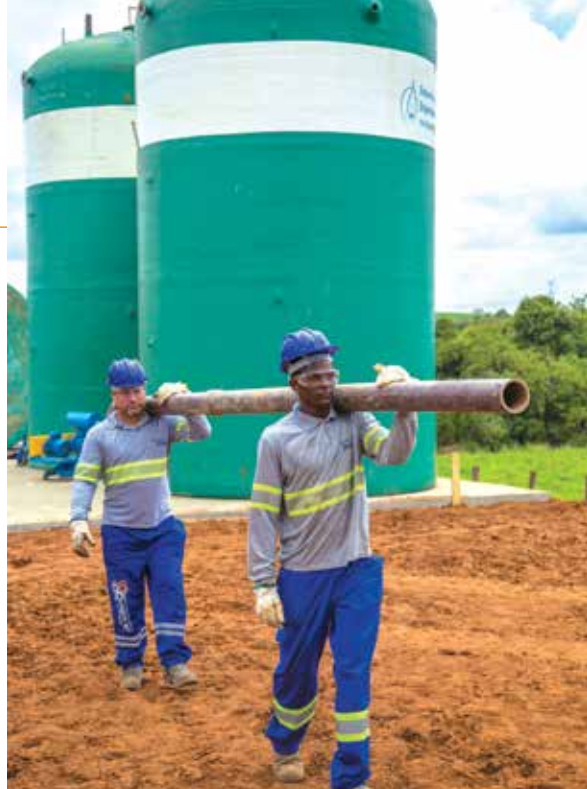
Construção da ETE no distrito de São Lourenço do Turvo, iniciada no segundo semestre de 2014.
