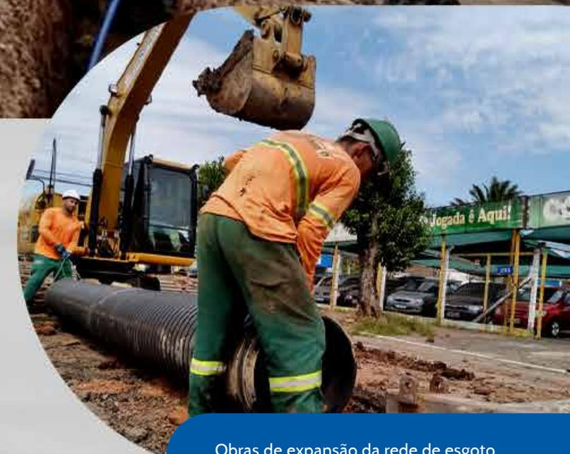
Obras de expansão da rede de esgoto realizadas pela Ambiental Metrosul.
