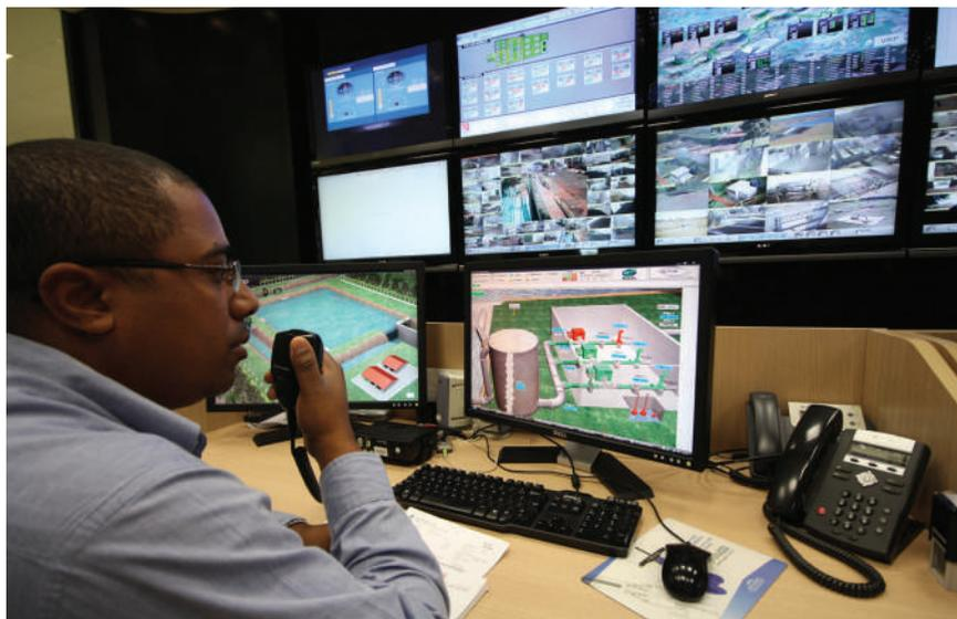
No terminal de Produção da Água, os técnicos acompanham a vazão e o nível nos reservatórios. E podem ligar ou desligar as bombas em função da reserva de água. Antes, um problema no abastecimento só era percebido quando chegava reclamação de um cliente.
