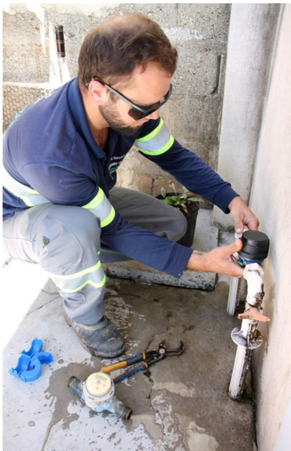
Além de substituir os hidrômetros danificados, as equipes instalam novos hidrômetros nas residências que ainda não tinham o equipamento.
